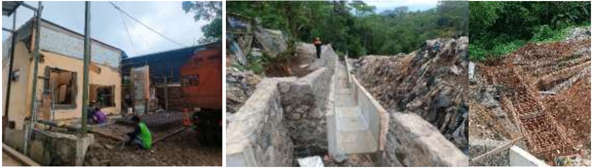
Gambar 25 Rehab dan Pembangunan di TPA Klegen (2025)
