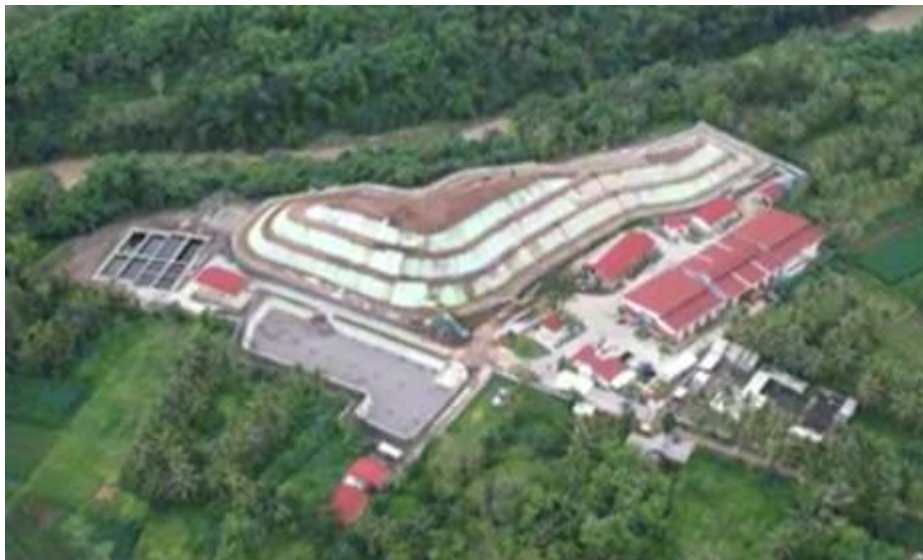
Gambar 27 kondisi TPST Pasuruhan Setelah terbangun
