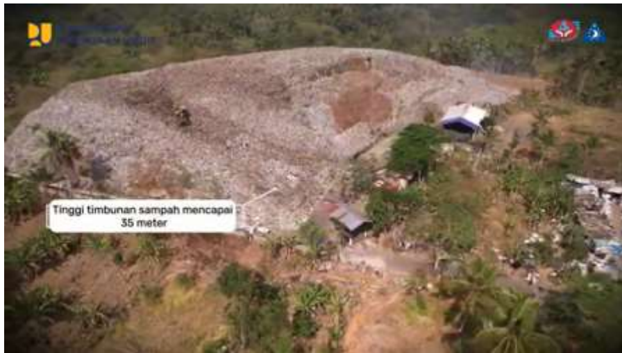
Gambar 26 kondisi TPA Pasuruhan Sebelum direhab
